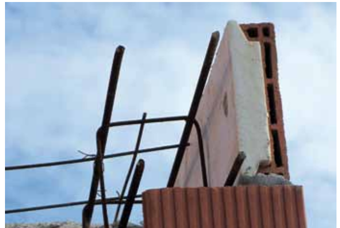
Aplacat de forjat
